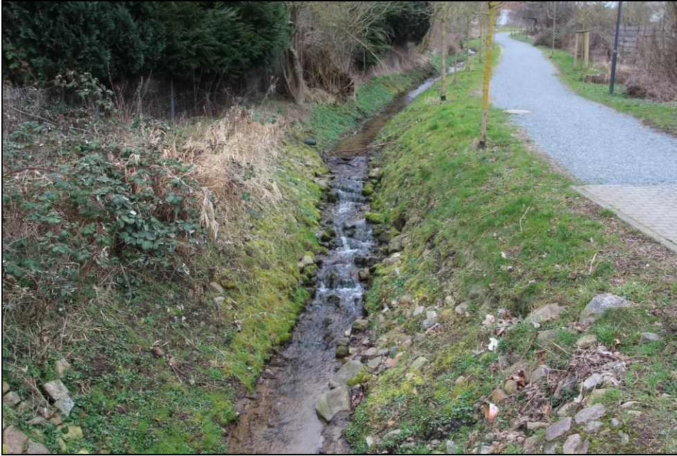
Abbildung 11: Graben oberhalb der Straßenquerung vom Kägsdorfer Landweg
