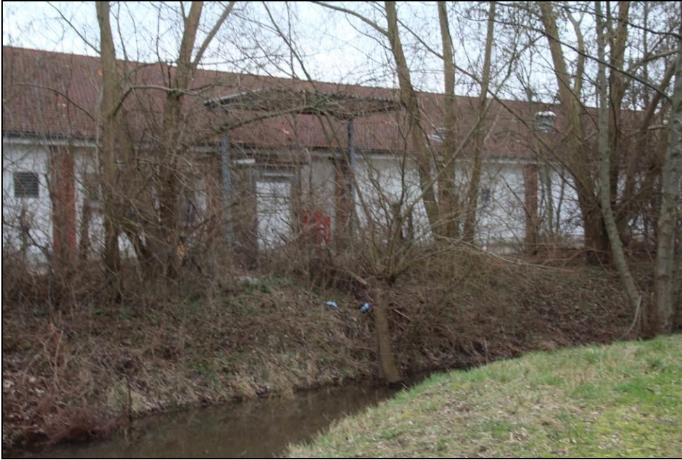
Abbildung 9: Bach/Graben im Bereich hinter dem alten EDEKA-Markt, hier fließt nichts mehr, der Bach/Graben ist hier durch den Rückstau des Regenwasserbeckens geprägt
