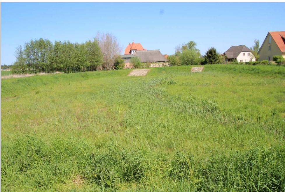
Abbildung 8: Regenwasserbecken außerhalb des Plangeltungsbereiches im Mai 2016, es ist nur noch ein Graben in der Mitte vorhanden
