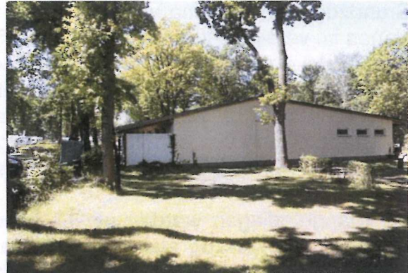
Geltungsbereich 2: bestehendes Sanitärgebäude mit vorgelagerter Spielfläche
