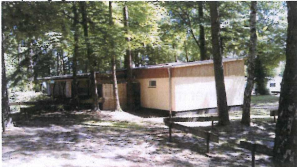
Geltungsbereich 3: bestehendes Sanitärgebäude
