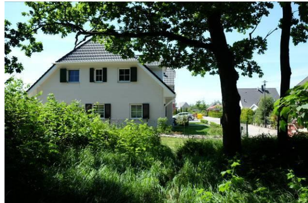
Bebauung im Wohngebiet Holmblick im Bereich der östlichen Ausfahrt.
