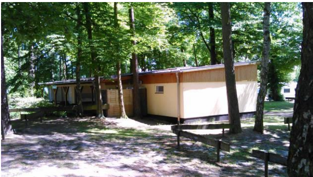
Geltungsbereich 3: bestehendes Sanitärgebäude
