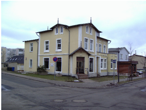
Gebäude in der Hermann-Häcker-Straße 16 (Flurstück 190/8, Flur 1, Gemarkung Kühlungsborn).
