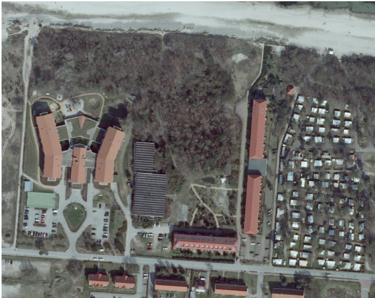
Luftbild des Plangebietes, Quelle: GeoBasis DE/M-V 2016
