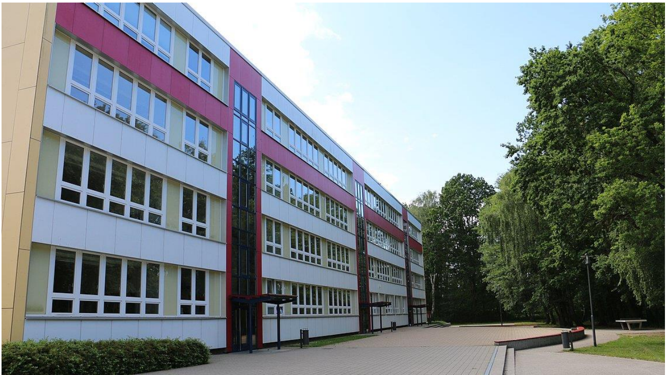
Abbildung 6: Ansicht 2 - Schulzentrum Kühlungsborn
