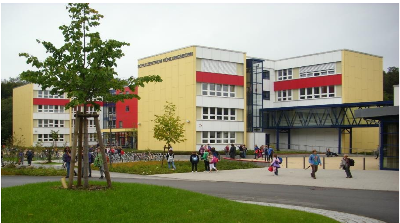
Abbildung 5: Ansicht 1 - Schulzentrum Kühlungsborn
