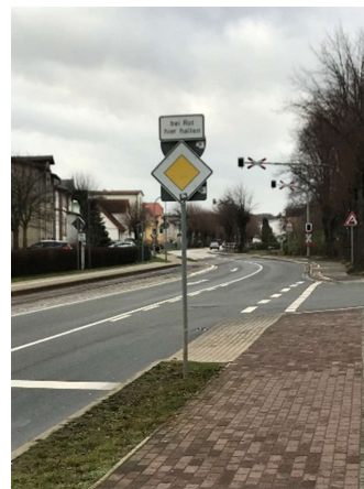
Blick von der Strandstraße nach Süden
