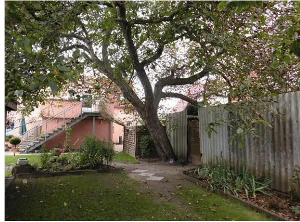
Abb. 4 hintere Ansicht des Gebäudes Poststraße 48 und geschützter Walnussbaum
