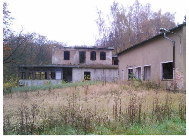
Das ehemalige Hause "Zur Kühlung" und das vorhandene, größere Wirtschaftsgebäude.
