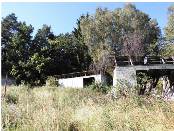
Ferienbungalows an der südlichen Grenze des Plangebietes.
