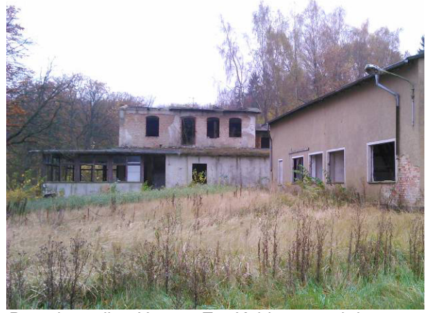
Das ehemalige Hause "Zur Kühlung" und das vorhandene, größere Wirtschaftsgebäude.
