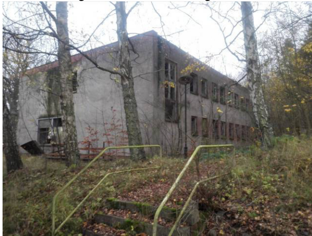
Das ehemalige Bettenhaus.
