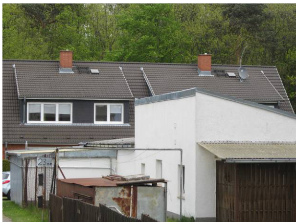
Neubau am Waldrand hinter Schuppen-Landschaft
