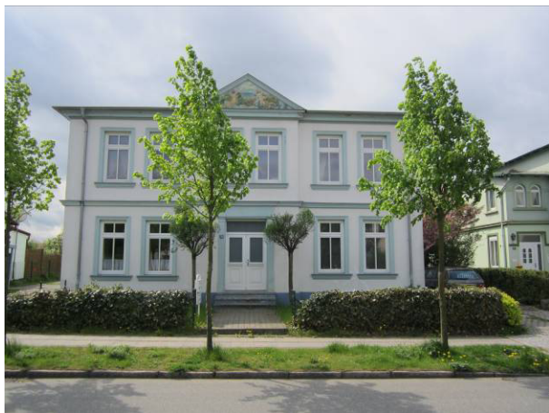
Klassische Kühlungsborner Bauweise im Osten der Neuen Reihe
