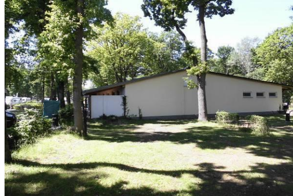
Geltungsbereich 2: bestehendes Sanitärgebäude mit vorgelagerter Spielfläche
