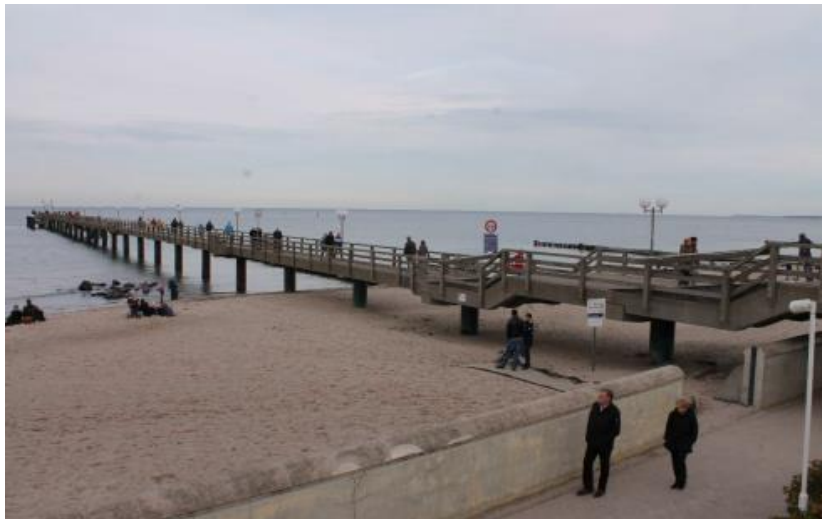
Bestehende 240 m lange Seebrücke
