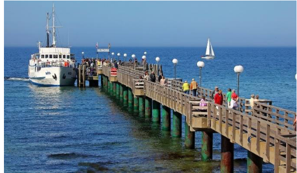
Abb. 05: Seebrücke Ostseebad Kühlungsborn (René Legrand).
