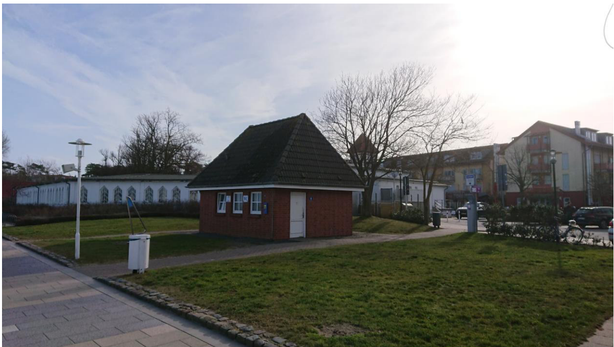
Abb. 39: Strandpromenade 20, WC-Gebäude (Quelle:DSK).
